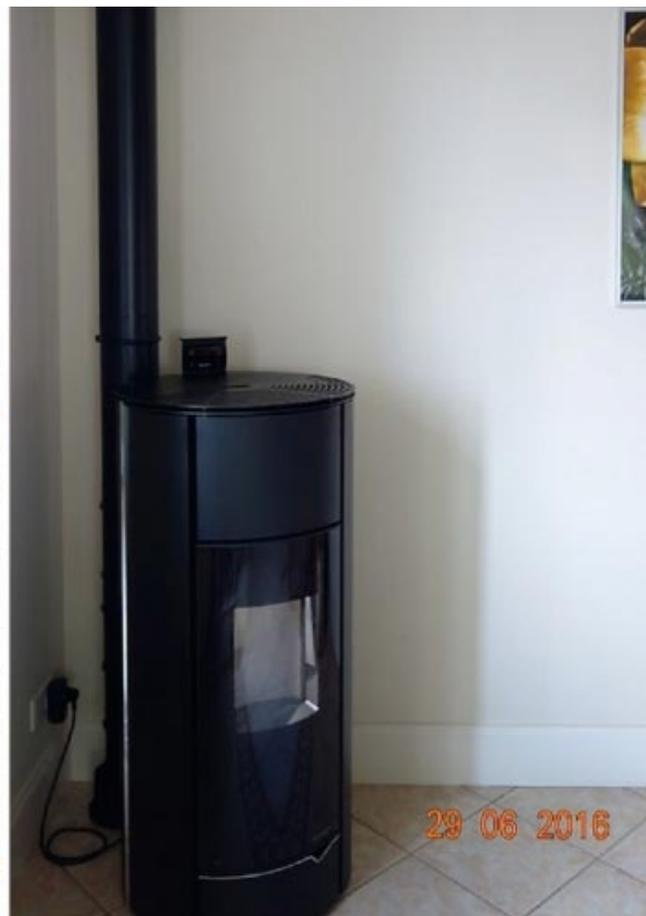
*Installation d'un poêle à granulés de bois en appoint . Installation en ventouse (zone 3) sortie sur mur horizontal. Obligation d'utiliser un poêle certifié étanche. Obligation d'utiliser un conduit concentrique.*
