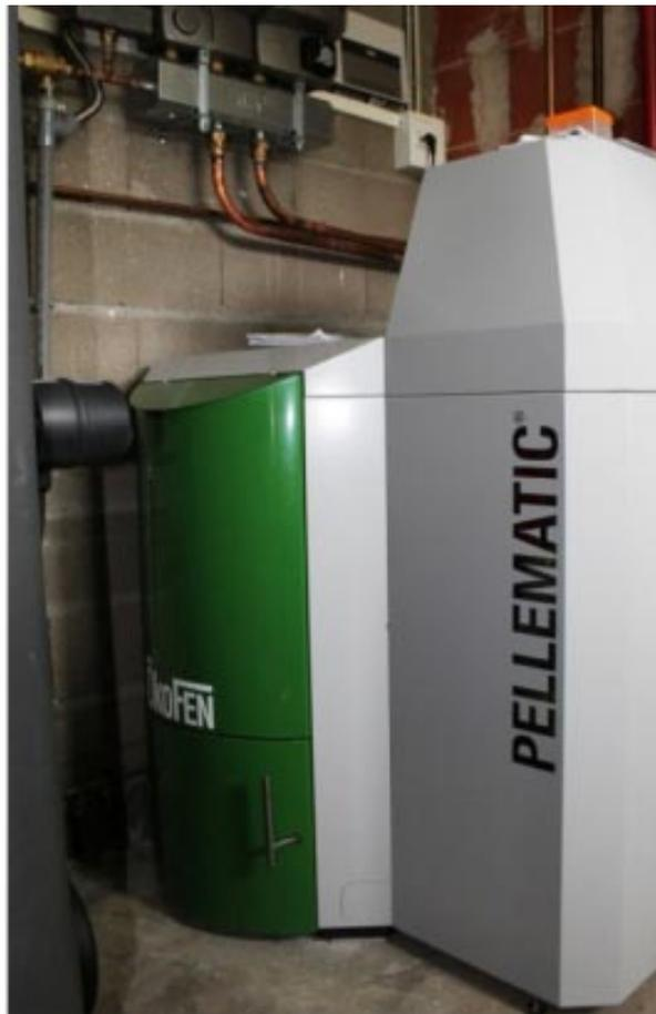
*Installation sur une semaine d'une chaudière à granulés OKOFEN 12 kw avec tuyau d'aspiration du silo à la chaudière. Prêt d'un silo textile de 450 kg en attendant d'acheter un silo plus grand. Installation également de 2 capteurs de CESI et de leur ballon d'eau chaude de 300L*
