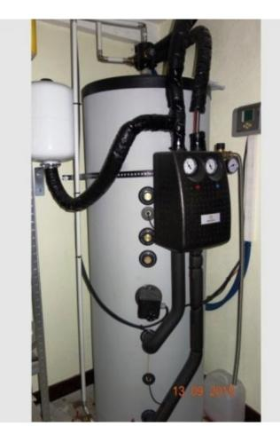
Installation d'un chauffe-eau solaire thermique de 300 litres. Exposition Est/Ouest. Taux de couverture des besoins annuels 70%.
