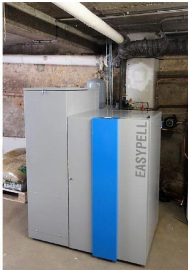
*Remplacement d'une chaudière fuel par une chaudière granulés de bois dans le cadre d'un projet de rénovation suivi par l'organisme ANAH
