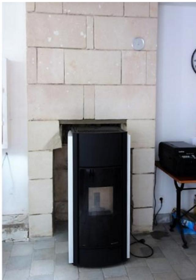
*Installation d'un poêle à granulés de bois comme chauffage principale en remplacement d'un insert à bûches :*
