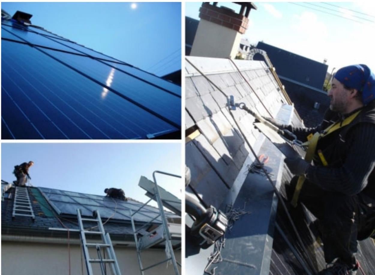
*Installation d'un champs solaire photovoltaïque de 2775 Wc intégré sur une toiture ardoise . Estimation de production BSA énergies : 2900 Kwh. Production réelle : 3000 Kwh. Projet géré totalement par BSA énergies : Etude Installation Raccordement*
