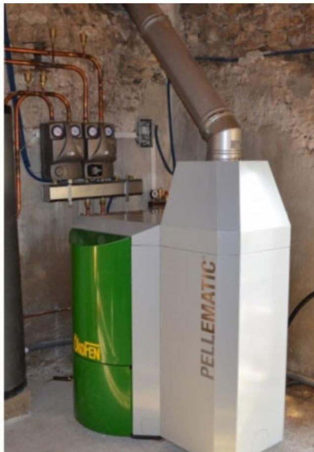
*RENOVATION MAISON 239 M<sup>2</sup> .Déperdition après isolation écologique : 15Kw. Installation chaudière granulés de bois Okofen de 15Kw plus sont silo 3,2Tnnes .Estimation de consommation 7 tonnes de granulés de bois. Gestion plancher chauffant au rez de chaussée + réseau de radiateurs à l'étage + eau chaude sanitaire.*
