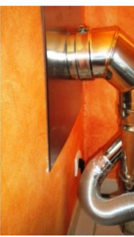
Poêle à granulés Palazzetti en complément d'un chauffage électrique à Veigné. Montage conduit concentrique pour installation étanche (zone 2)
