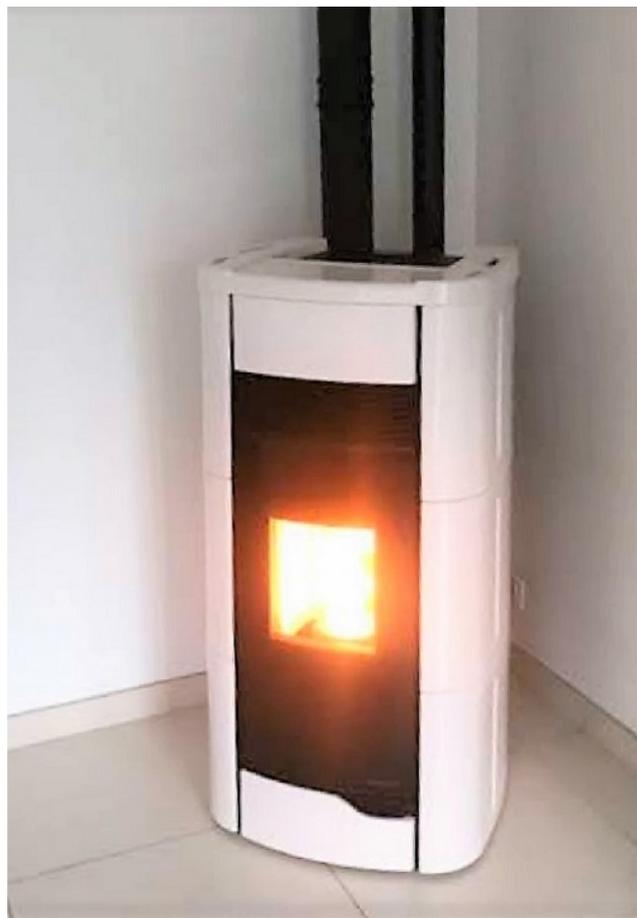
*Installation d'un poêle à granulés de bois en complément d'un chauffage électrique Utilisation d'un poêle canalisable pour alimentation en air chaud 2 pièces adjacentes*
