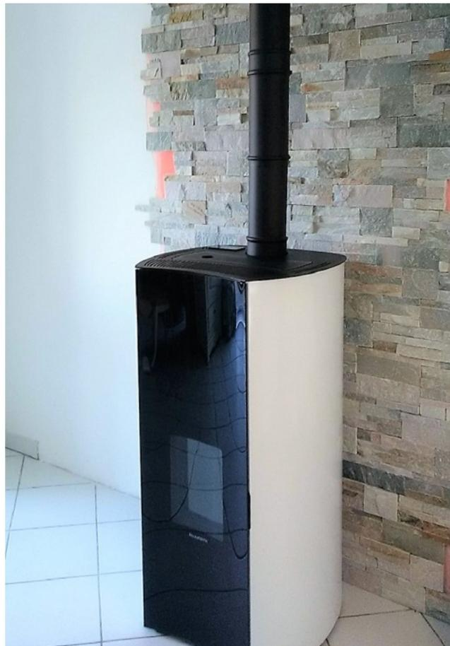
*Installation d'un poêle à granulés de bois en remplacement d'une cheminée ouverte
