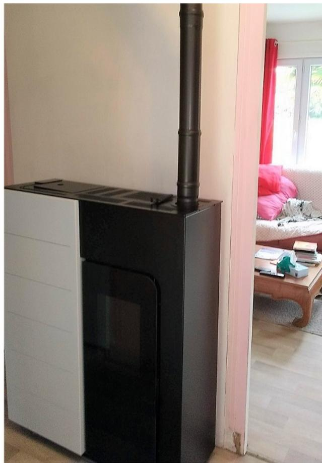
*Installation d'un poêle à granulés de bois comme chauffage principal en remplacement d'un chauffage gaz propane Canalisation d'air chaud dans pièce de vie adjacente*
