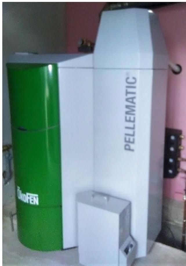
*Création d'une chaufferie à granulés de bois Okofen 25 kw pour alimentation de 3 bâtiments avec création d'un réseau de chauffage enterré
