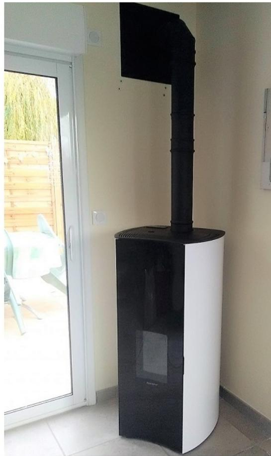
*Installation d'un poêle à granulés de bois dans une extension bois avec sortie du conduit de fumées en ventouse zone 2 Meilleur confort Economique Convivial*
