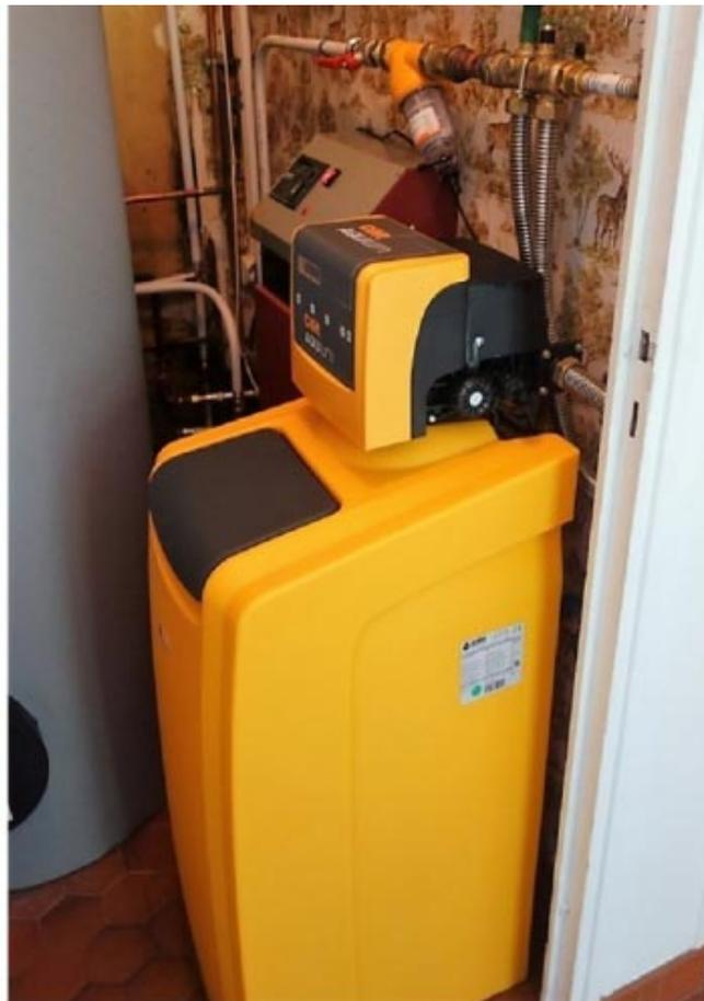
*Mise en place d'un adoucisseur Cilit afin d'abaisser le taux de dureté de l'eau (titre hydrotimétrique TH ) 34 °f à 10 °f et de protéger le ballon solaire ainsi que l'ensemble de la maison.*
