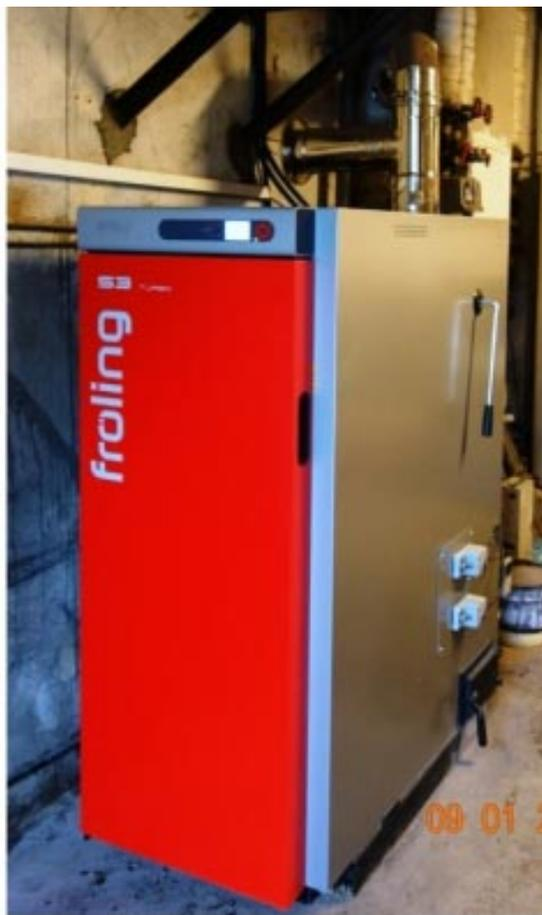
Mise en place d'une chaudière bûches avec son ballon tampon de 1800 litres pour chauffer une maison de 200 m<sup>2</sup> Nombre de chargement jour
