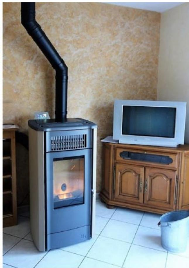
*Installation d'un poêle à granulés de bois en remplacement d'un poêle à granulés de bois mal dimensionnée
