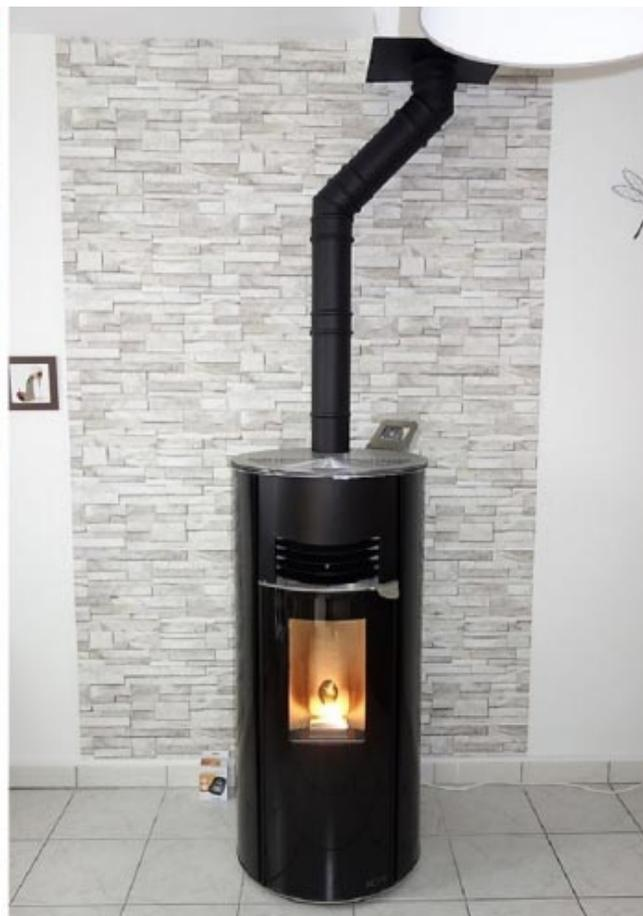
*Installation d'un poêle à granulés de bois en remplacement d'un insert bûche
