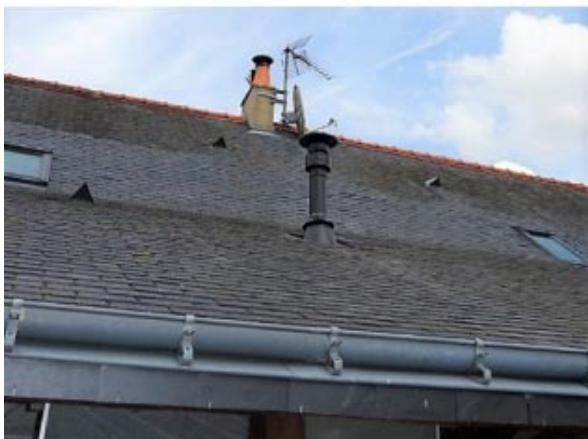
*Installation d'un poêle à granulés en complément à un insert bûches dont la puissance est trop faible.
