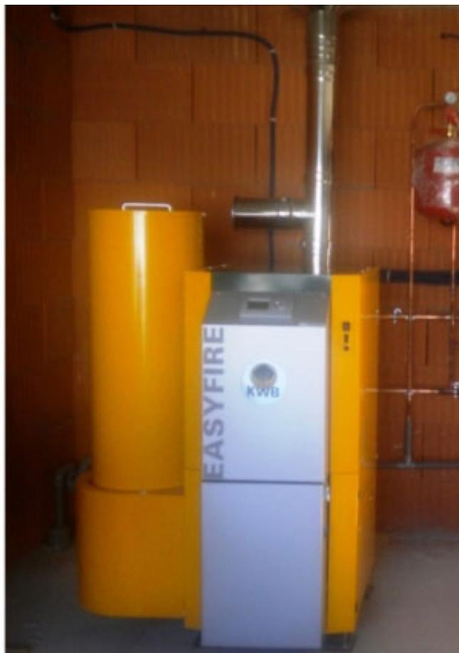
*CONSTRUCTION MAISON BBC 170m<sup>2</sup>. Déperdition 6,8 Kw. Gestion d'un réseau de radiateurs basse température pour l'ensemble de la maison et de l'eau chaude sanitaire avec un système solaire combiné (7m<sup>2</sup> de panneaux solaires et ballon 400 l) .Taux de couverture solaire estimé en chauffage (30%) et eau chaude sanitaire (70%). Une chaudière granulés 8 Kw à chargement manuel assure l'appoint chauffage et eau chaude.*
