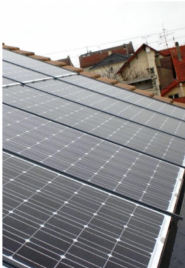
*INSTALLATION D'UN CHAMPS SOLAIRE PHOTOVOLTAÏQUE 2960 Wc . Intégration des panneaux photovoltaïques sur toiture tuile.
