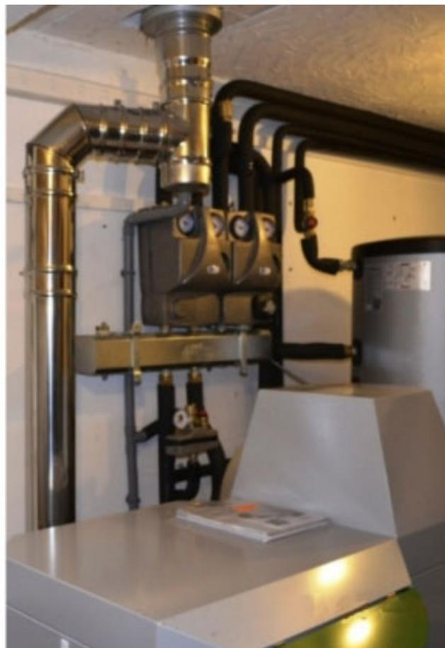
*Chaudière granulés de bois Okofen en remplacement d'une chaudière Gae Propane, Assure le chauffage et l'eau chaude sanitaire, couplage avec une production solaire thermique.*
