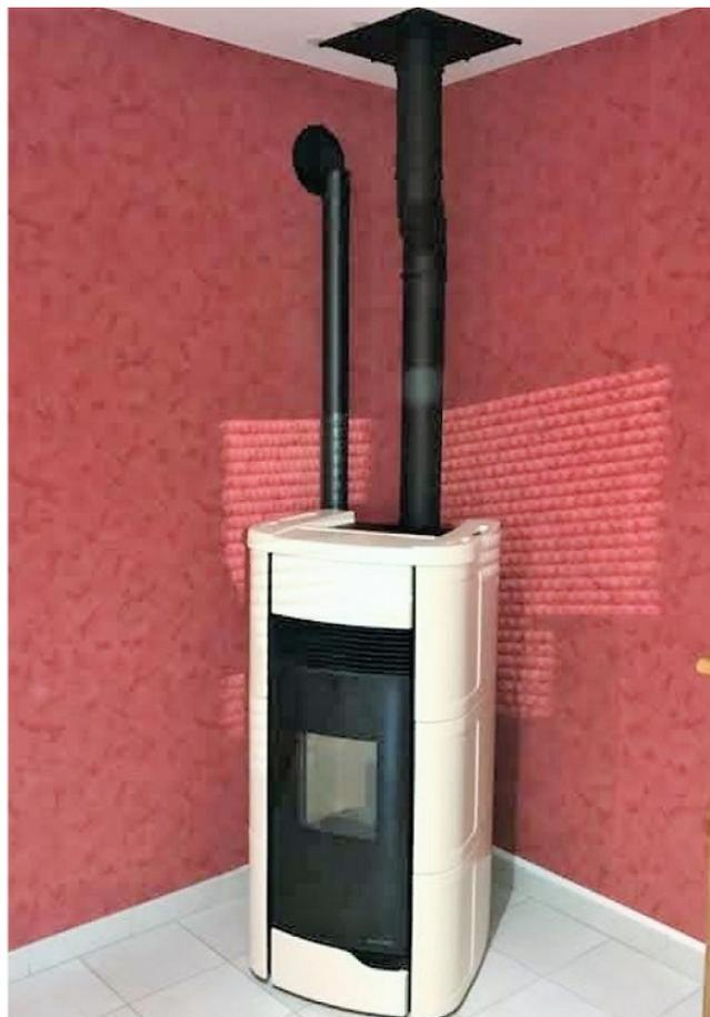
*Installation d'un poêle à granulés de bois en appoint à un chauffage électrique pour plus de confort et une économie d'énergies électrique Installation d'un canalisation sur pièce adjacente (cuisine) pour diffusion de chaleur plus homogène*
