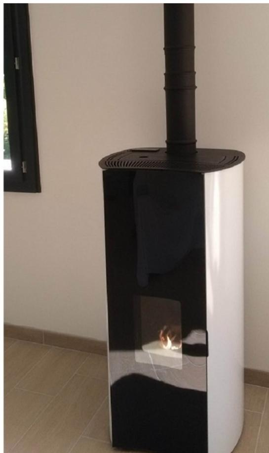
*Installation d'un poêle à granulés comme chauffage principale avec un conduit de fumées ventouse (zone 2)*
