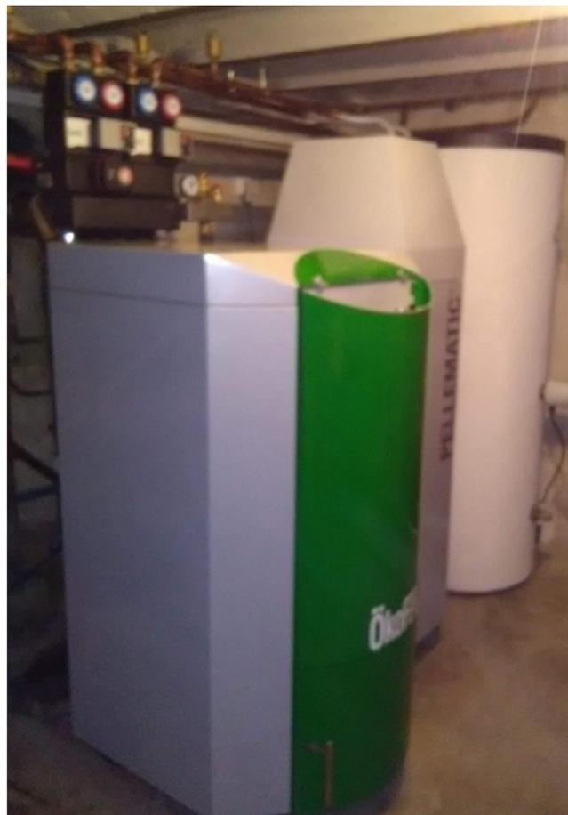
*Remplacement d'une chaudière Fuel par chaudière à granulés de bois comme chauffage principale plus traitement eau chaude sanitaire .Installation Silo granulés 3 tonnes pour approvisionnement par camion souffleur vrac Grace au groupement achat BSA énergies le prix, la qualité et les délais de livraisons du granulé sont optimisés*
