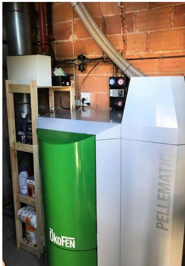
*Remplacement d'une chaudière fuel par une chaudière à granulés de bois comme chauffage principale pour une surface de 180 m<sup>2</sup>*
