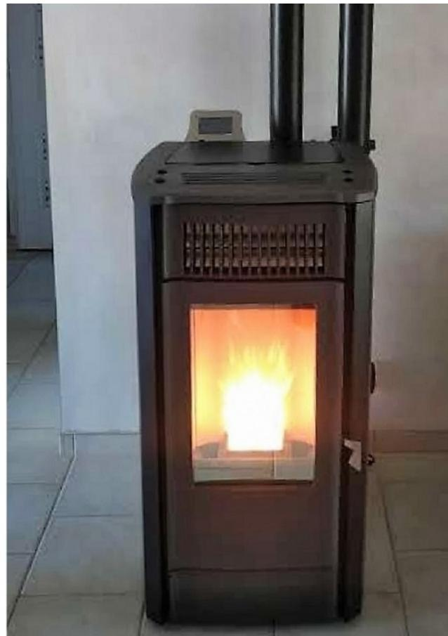
*Remplacement d'un insert bûches par un poêle à granulés Hoben avec canalisation d'air chaud pour reprise de réseau existant Grosse autonomie (38 Kg)*
