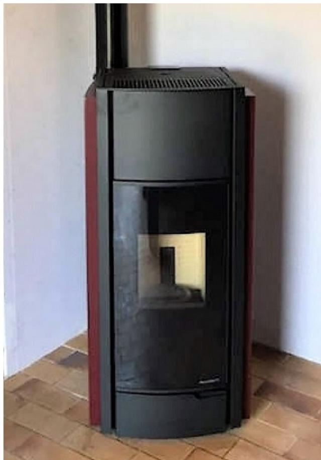
*Remplacement d'un insert bois bûches par un poêle à granulés de bois comme chauffage principal et création d'une canalisation d'air chaud pour alimentation pièce adjacente*
