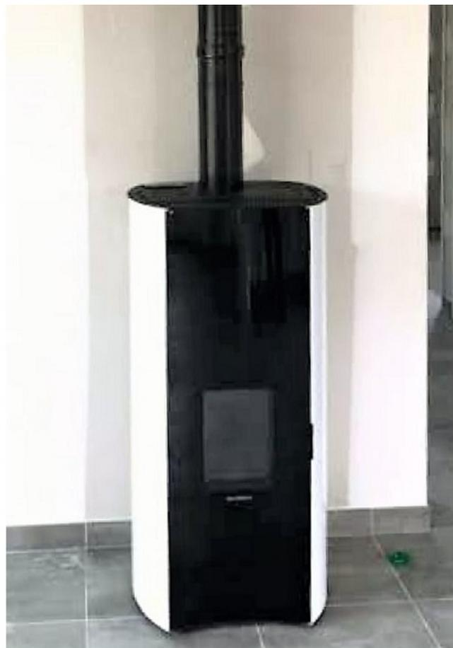
*Installation d'un poêle à granulés de bois dans maison neuve type RT2012 comme chauffage principal 100m<sup>2</sup> Habitable Sans conduit de distribution*
