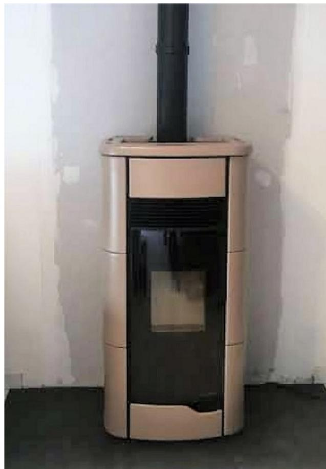
*Remplacement d'un insert bois par un poêle à granulés de bois comme chauffage principal pour une maison de 90 m<sup>2</sup>Optimisation de l'installation avec un poêle dont la sortie de fumées est réalisée par le dessus du poêle*
