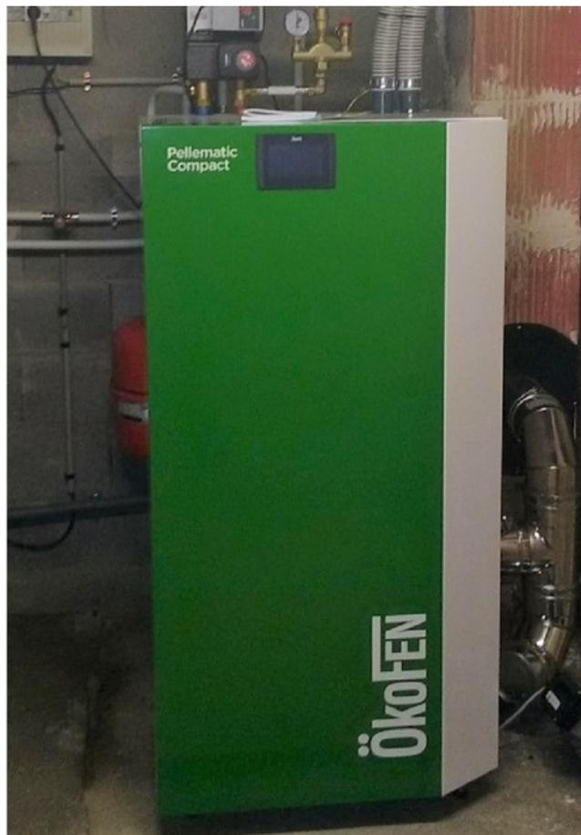
*Remplacement d'une chaudière Fioul par une chaudière à granulés de bois comme chauffage principal Réalisation d'un silo sur mesure (réalisé par le client)*
